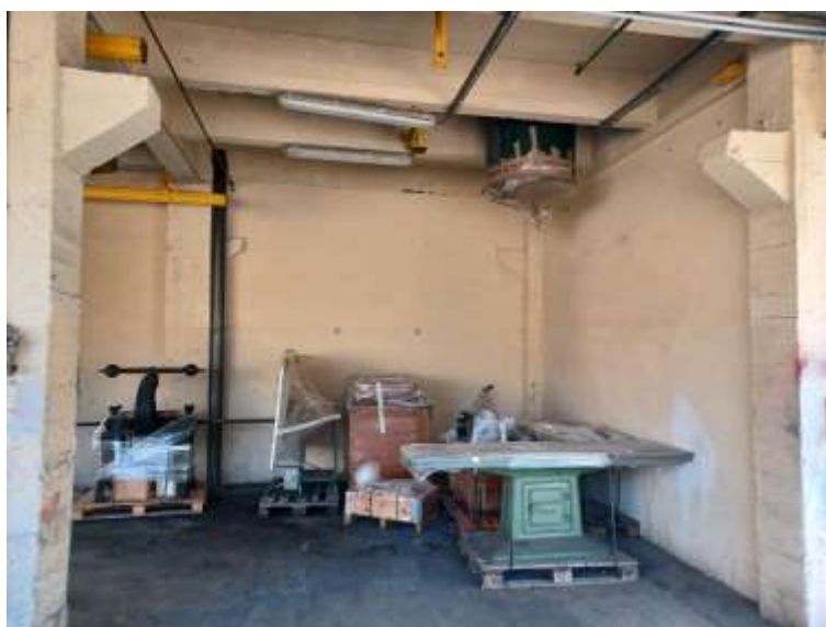
Figure 6 : Emplacement de l'ancienne cabine de peinture qui a été évacuée
